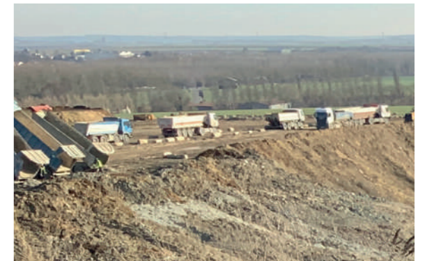
Site d'ECT de gestion et de réutilisation des terres excavées à Villeneuve-sous-Dammartin.
