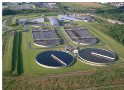
Station d'épuration © Arras communauté urbaine.
