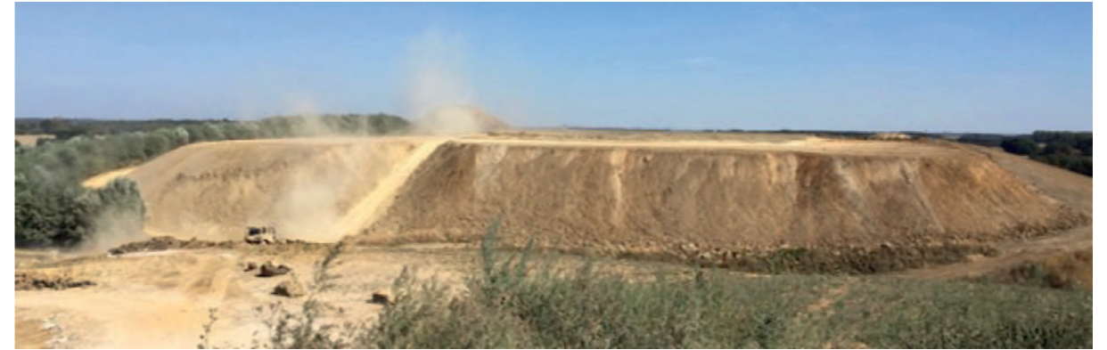
Site d'ECT de gestion et de réutilisation des terres excavées à Moissy-Cramayel.
